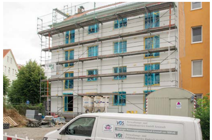
Bei der Hersfelder Straße 18 war Ende Juli der westliche Teil der Fassade gedämmt und verputzt.
