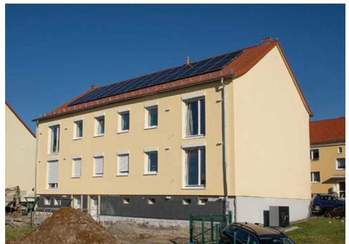
Ende Juli wurde in der Bertolt-Brecht-Straße der Anbau der Balkonanlage mit Balkonkraftwerken vorbereitet.
