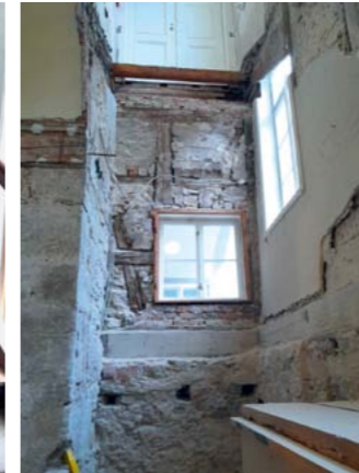
Hier entstand später der neue Aufzugsschacht.
