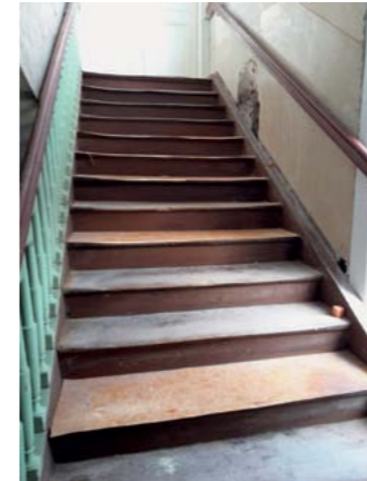
Das historische Treppenhaus wurde zurückgebaut.
