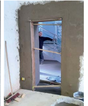
... in Handarbeit ein Zugang für den Aufzug eingebracht.
