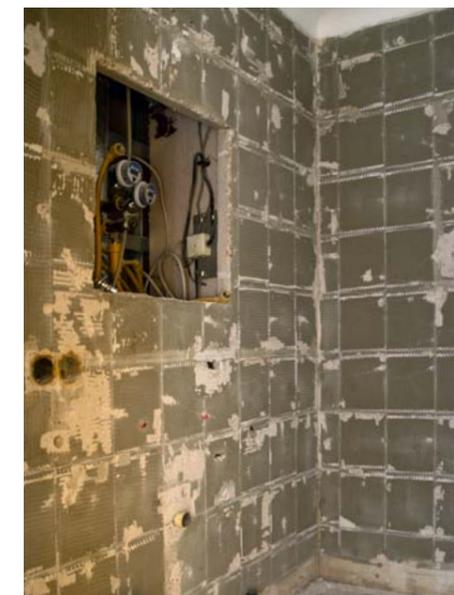
Bei allen Bädern werden anfangs Sanitärkeramik, Installationen und Fliesen inkl. Kleberreste vollständig entfernt.
