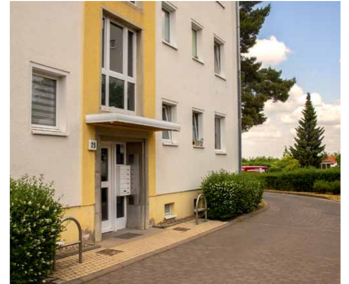
Im Objekt Heinrich-Heine-Straße 25 mit sechs Wohnungen wurde in diesem Jahr eine von mehreren Strangsanierungen umgesetzt.
