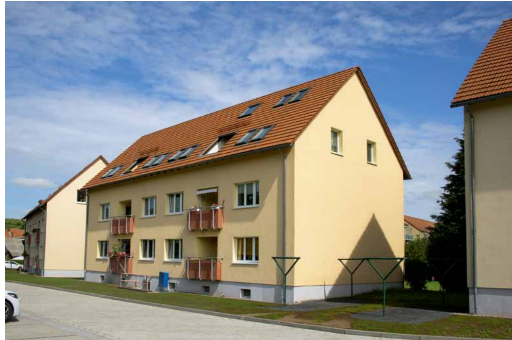
Ein neues Nahwärmenetz wurde in Gräfenroda in der Straße der Einheit in diesem Jahr für zwei Gebäude errichtet. Im kommenden Jahr wird ein drittes Gebäude daran angeschlossen.
