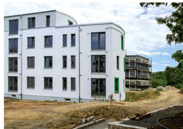
Die Fassade von Haus 2 wurde Mitte Juli bereits für den Anbau der Balkone vorbereitet. Und die Fassade von Haus 3 war fast vollständig gedämmt.
