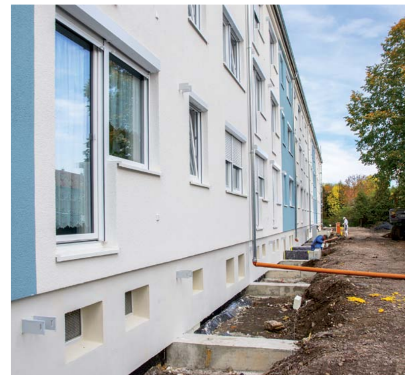
Ende Oktober waren die Fundamente für die neue Balkonanlage bereits gesetzt.
