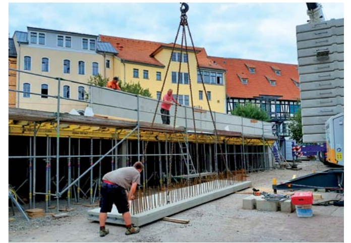
Im August montierten wir „An der Weiße“ meterlange und tonnenschwere Betonplatten für ein Parkdeck.
