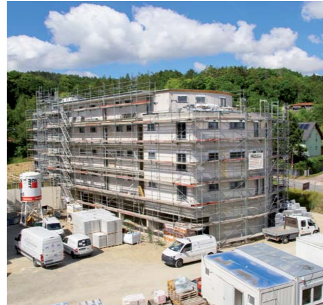
Die Fassade von Haus 1 wird gedämmt und der Innenausbau schreitet weiter voran.
