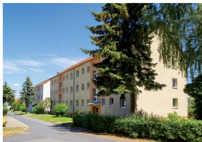
Die vier Gebäude in Gräfenroda, Straße des Aufbaus 1–15, werden durch eine Wärmeerzeugungsanlage versorgt, welche durch unser Tochterunternehmen VGS im letzten Jahr erneuert wurde und seitdem betrieben wird.
