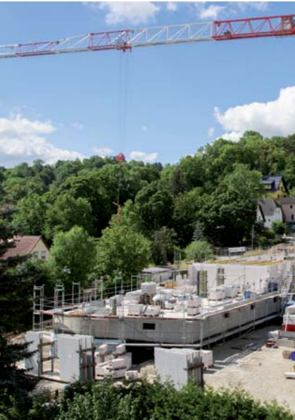
Der Rohbau von Haus 3 ist gerade im Entstehen.
