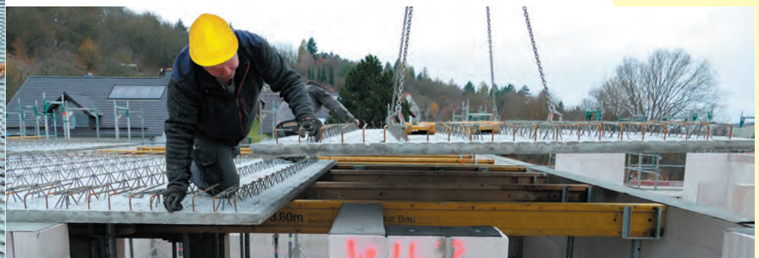
Mitarbeiter der Firma Constructor Bau GmbH beim Setzen der Baurundungen und rechts beim Verlegen der Geschosßdecken.
