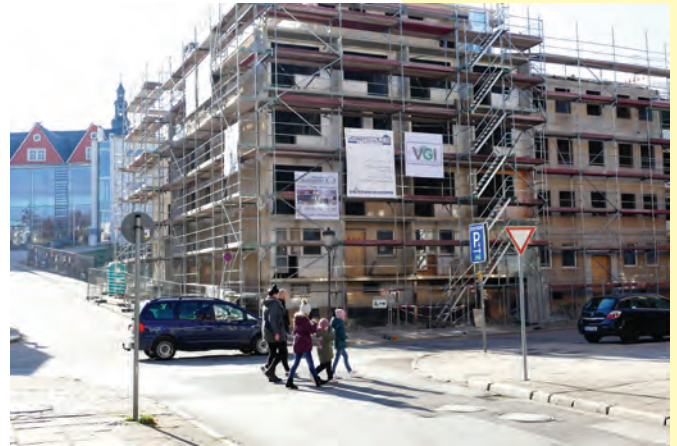
Baustelle An der Weiße. Eine gute und bewährte Zusammenarbeit mit der WBG Arnstadt gibt es auch in diesem Jahr.
