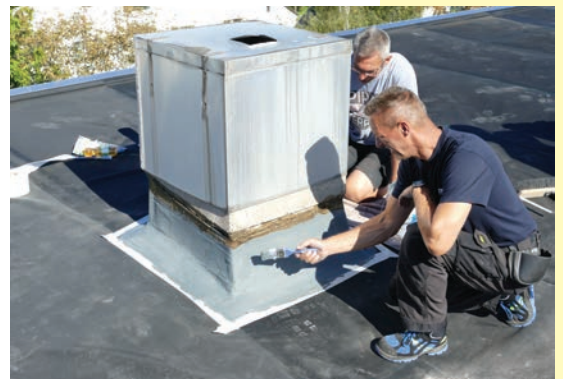
Veit Goblirsch (im Bild vorn) und Firmeninhaber André Nötzel bei der Verdichtung der Entlüftungskanäle.
