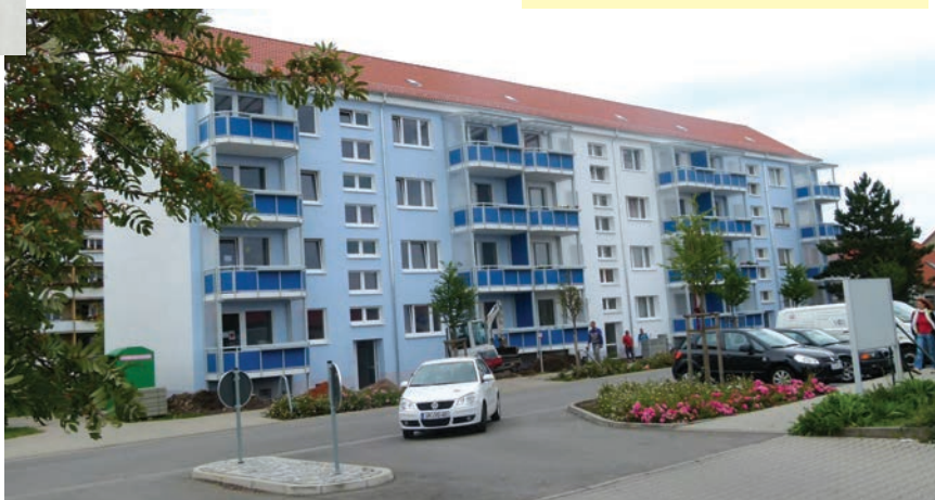
Ichtershausen, Wohnhaus Wachsenburg Straße
