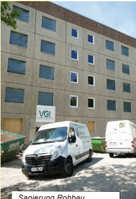
Sanierung Rohbau Weimar - Moskauer Straße
