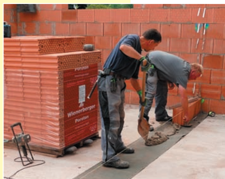
Stein auf Stein. In Marlshausen hat das VGI-Team beim Bau der neuen Turnhalle deutliche Qualitätsspuren hinterlassen.
