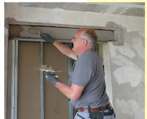
Fummelarbeit mit Geduld. Hanko Heinze (links) beim Verkleiden eines Türsturzes mit Putzträger. Michael Bock beim Anputzen eines solchen Trägers. Beide Mitarbeiter der VGI trafen wir im 4. Obergeschoss, Rückfront und Giebel werden schon für die Fassadendämmung vorbereitet und sind komplett eingerüstet. Mittleres Bild: Vorbereitungen für die Fassadendämmung.
