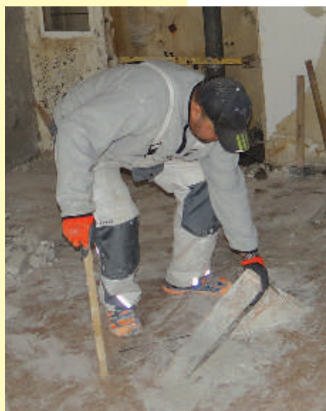
Michael Ruttmann beim Entkernen
