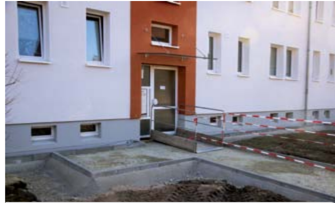
Vor jedem Hauseingang entsteht ein Fahrradstellplatz.
