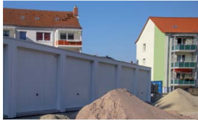
Die Garagen wurden im September 2021 aufgestellt.
