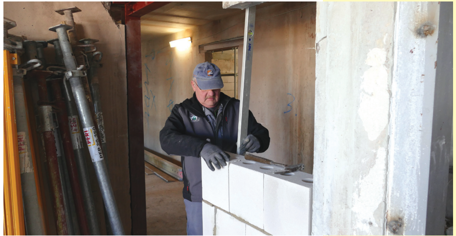
Michael Bock von der VGI traf wir beim Einziehen einer Mauer in dem Rudolstädter Sanierungsprojekt in der Trommsdorfstraße an. Die Mitarbeiter Hanko Heinze, Denny Gabler und Nico Messer sind derzeit damit beschäftigt, im Innenbereich die neuen Grundrisse der Wohnungen zu realisieren. Mit der guten alten Handwerkskunst Stein auf Stein, auch wenn es diesmal Gasbetonsteine sind.
