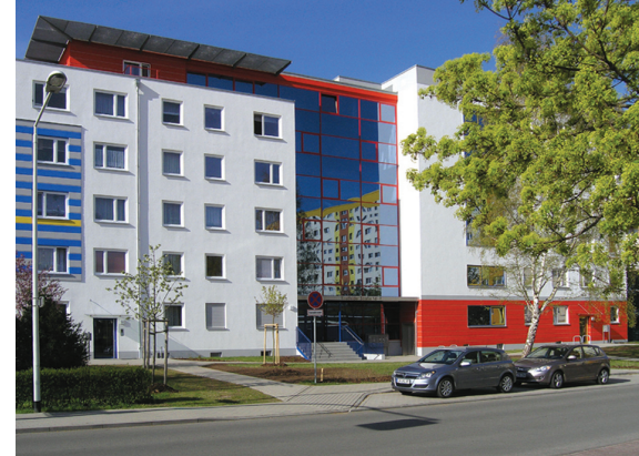
Sanierung Saalfelder Straße 1d-f, 2009
