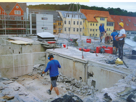
An der Weiße baute die VGI nicht nur das Dach ab, sondern auch einen Aufzug an.
