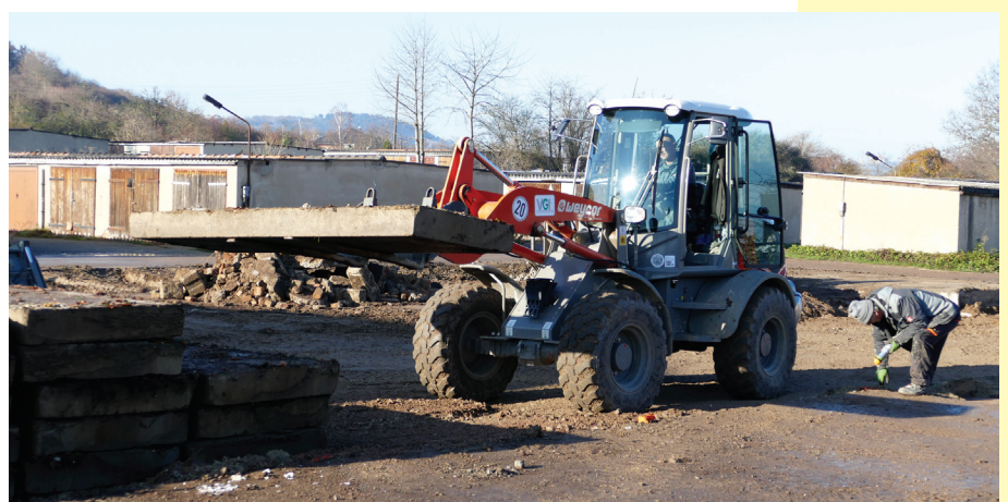
Mit dem Aushub von Betonplatten begann schon die Vorbereitung der Grundfläche.
