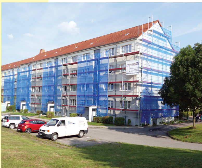
Anfang September zeigte sich die Turnvater-Jahn-Straße noch eingerüstet, inzwischen stehen die Arbeiten kurz vor ihrem Ende.
