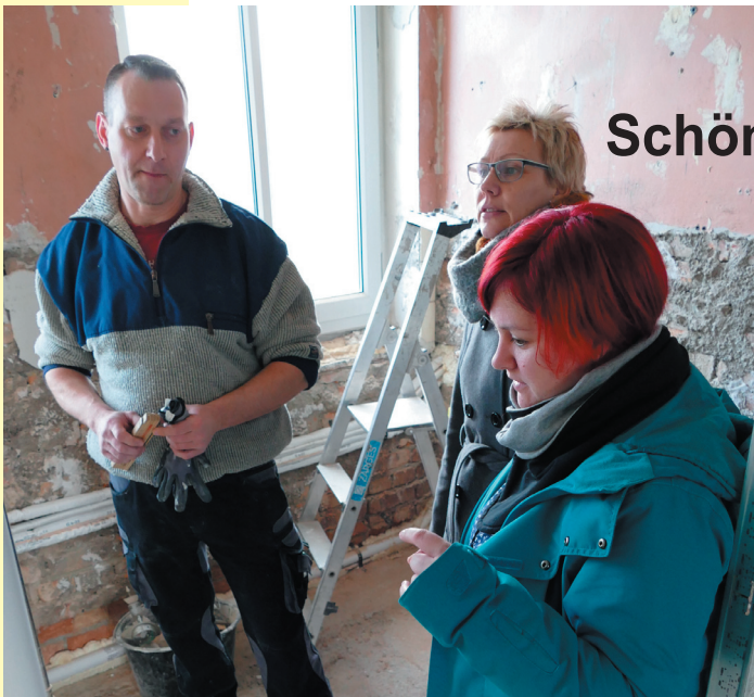
René Feige, Bauunternehmer und VWG-Partner, im Gespräch mit Tina Lempa und Simone Rödiger. Das Bad wird komplett umgebaut, auch Trockenbauwände wurden eingezogen.
