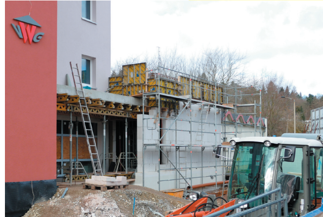
Der Baufortschritt ist nicht zu übersehen!
