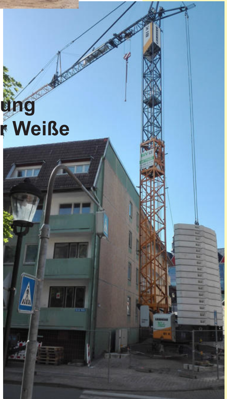
Der Baukran wurde schon im Mai aufgestellt...
