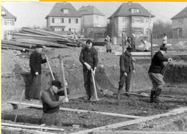
Baubeginn Gothaer Straße
