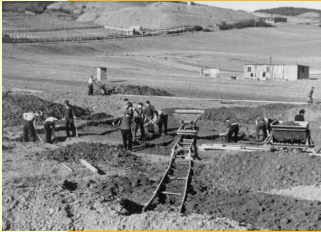
Baubeginn Arnstadt West/Alt
